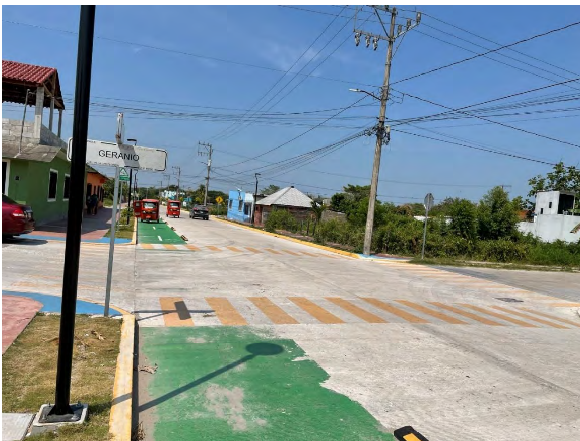
Ilustración 41. Calle Tulipanes (vialidad secundaria)
