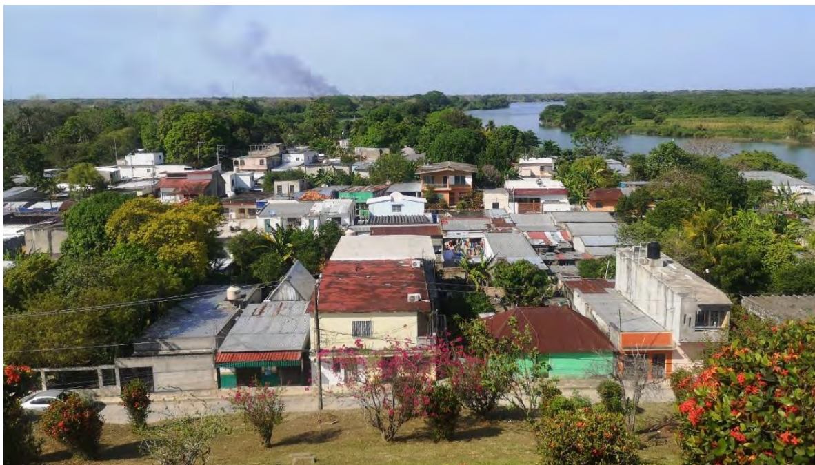
Ilustración 29. Viviendas del primer cuadro de la cabecera de Jonuta
