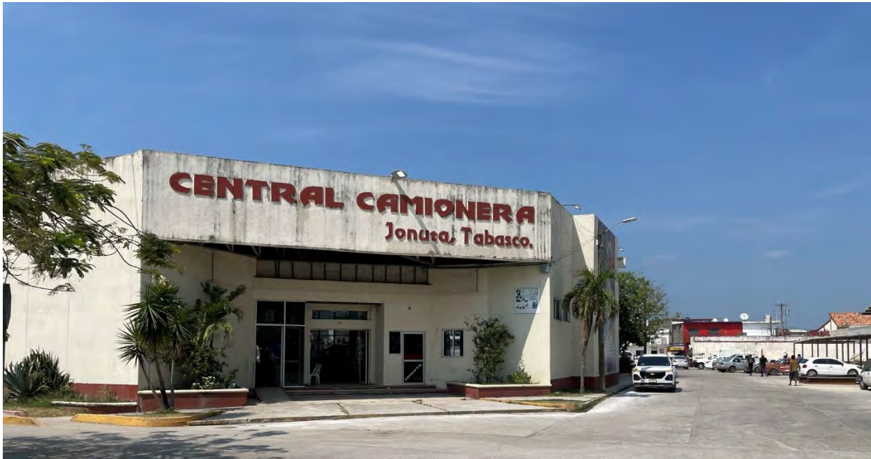
Ilustración 34. Central camionera de Jonuta.
